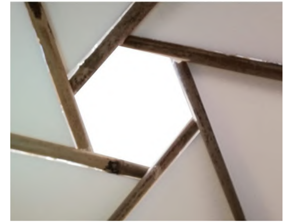
Vue au dessus de la toiture
