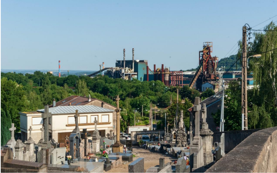
Usine sidérurgique dite « de Florange », vue depuis la côte des Vignes à Hayange-Marspich avec au premier plan, le cimetière de Marspich (juin 2022, Julien Maion)
