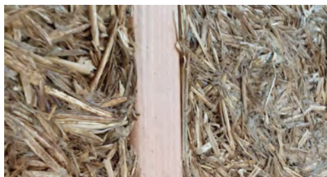
Détail sur terre allégée - Ferme des Quat'Saisons - ABA & Eskaapi
