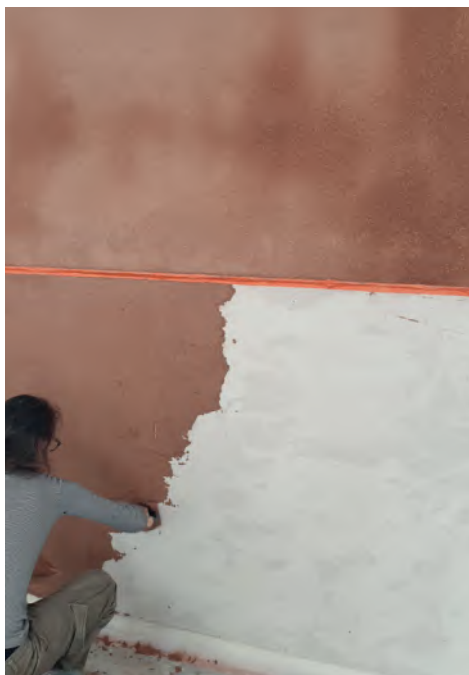
Application de l'enduit sur le support
