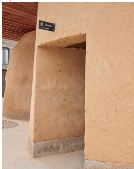
Exemple de mise en oeuvre de la bauge à la gare de Dinan - Atelier alp
