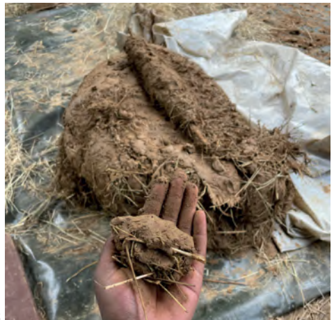
Mise en oeuvre du torchis au cour d'un chantier participatif, automne 2023
