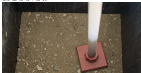
Mise en oeuvre de la matière «terre» à la force du pisoir manuel dans un coffrage
