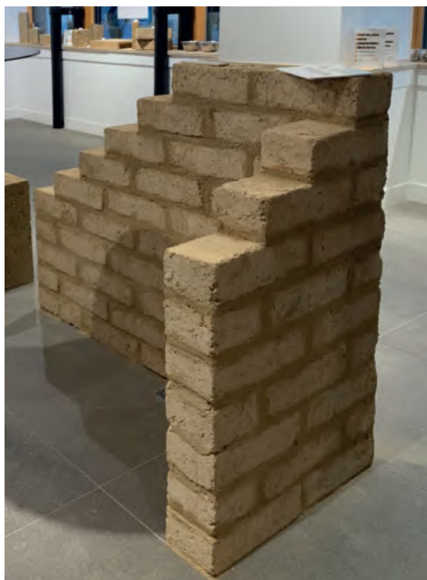
Prototypé de maçonnerie d'adobe en cloisonnement - Fabriqué par le Collectif francilien de la terre crue (Maude, Antonin). Adobes données par la Ville de Rosny-Sous-Bois, fabriquées en chantier participatif à l'aide d'un moule en bois.
