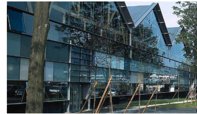
CENTRE DE RECHERCHES SAINT-GOBAIN, AUBERVILLIERS, 2000
